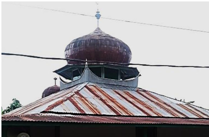
Gambar 4, Atap Surau Cerobong Sumber: Dokumentasi Pribadi
