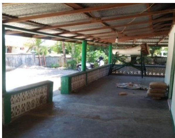
Gambar 6, Teras dan Serambi Surau Cerobong Sumber: Dokumentasi Pribadi
